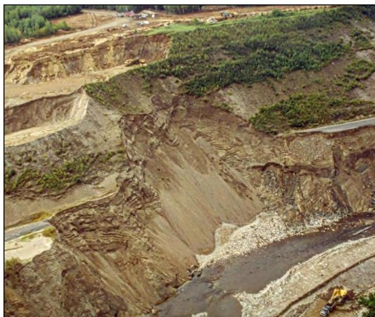
Figure 12 - Croquis et photo d'un glissement superficiel profond.
