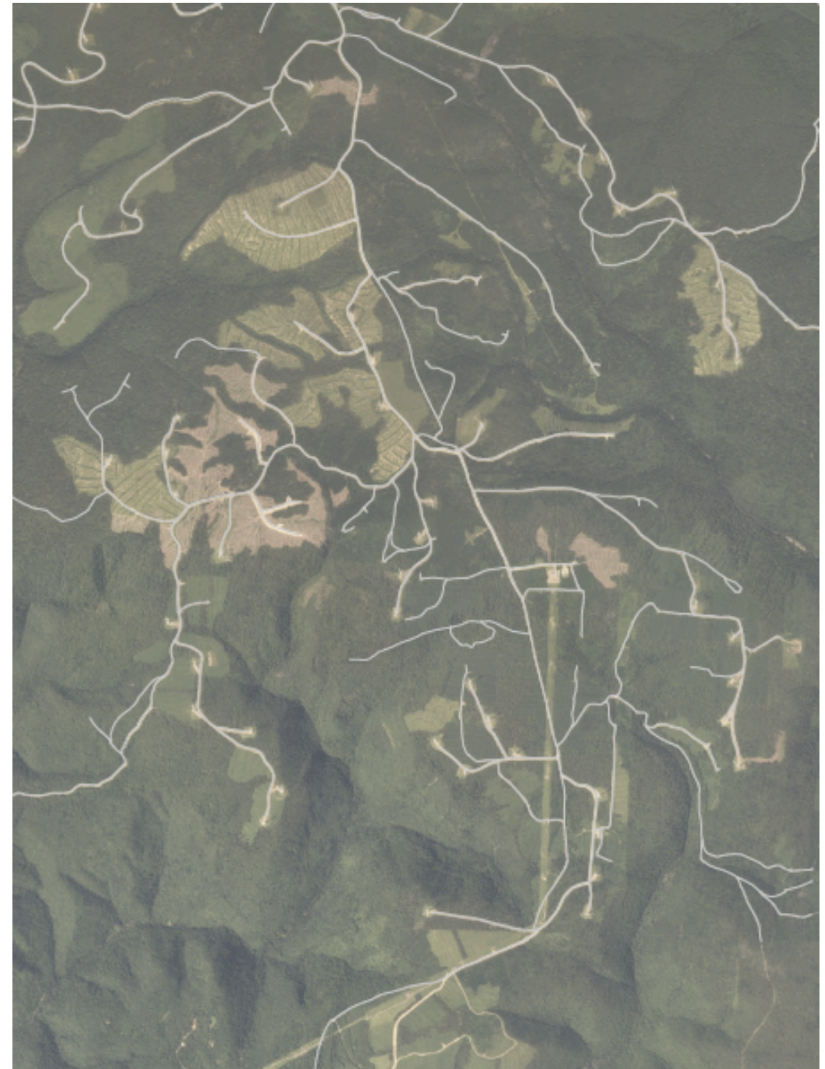
Les chemins forestiers zigzaguent dans tout l'arrière de la MRC. Ici, on observe un parc éolien à l'arrière de Carleton-sur-Mer.
